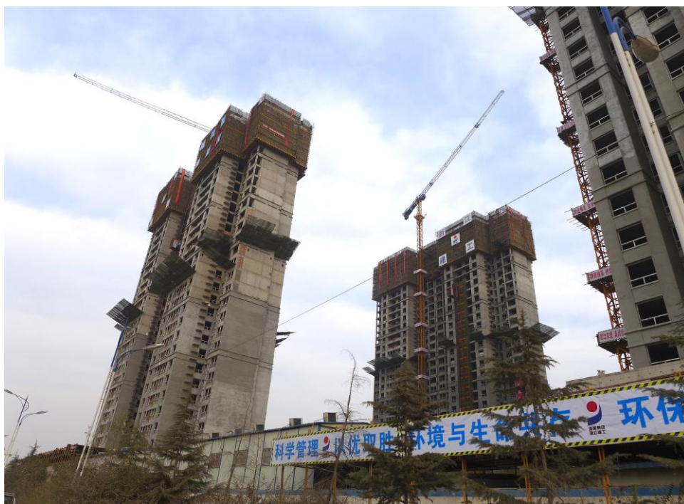
▲ 加紧建设中的西电集团职工高层住宅楼
