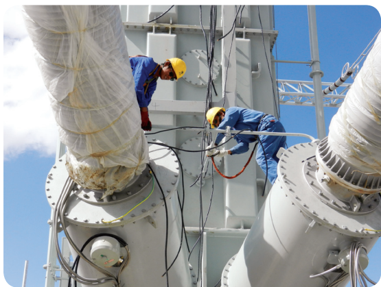
服务人员在现场精心安装
