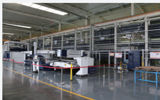
宝鸡电气 开关柜装配 3 号线和钣金加工柔性 T 线
