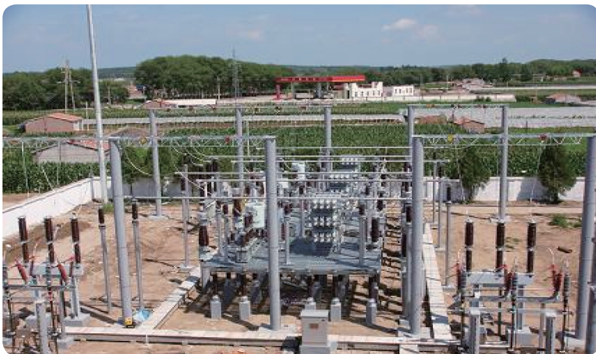
参与建设的阜新 66kV 固定串联补偿工程，可提高电力系统的稳定性，增加输电线路的输送能力，改善系统的电压调整和无功平衡
