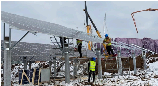
项目人员抢时间、赶进度
