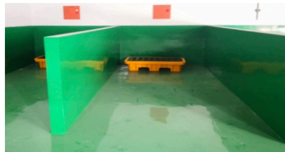
危险废物储存场所
